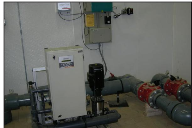
Figura 4. Sistema de Inyección de Fertilizantes
