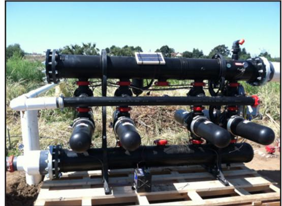
Figura 2. Ejemplo de un Netafim Apollo Disc-Kleen Filter
