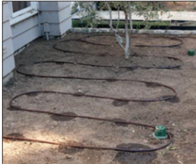
La foto de abajo muestra línea de goteo Techline instalado en una fuerte pendiente.
