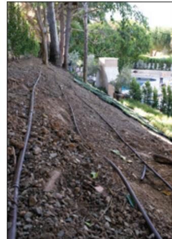
Las fotos anteriores muestran tubería Techline colocado en parterres, encima de la tierra, lista para ser cubierto con pajote.
